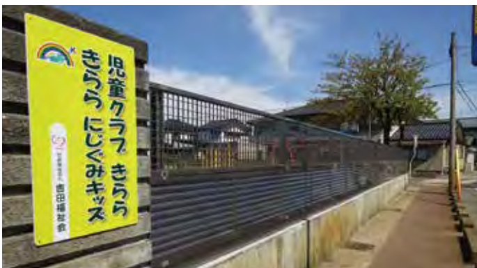
▲新しくなった外周フェンス
